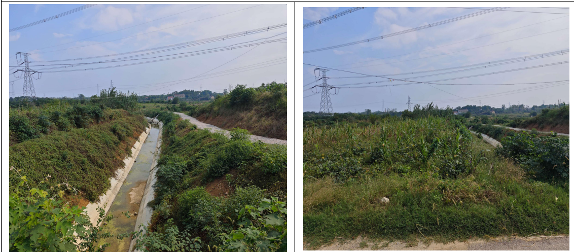
支渠两侧植被恢复 (2025.11.10)
