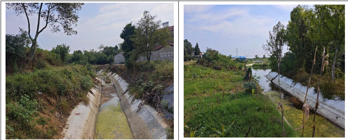
支渠两侧植被恢复 (2025.9.28)
