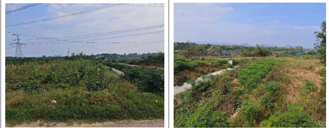
施工场地拆除后复耕 (2025.9.28)
