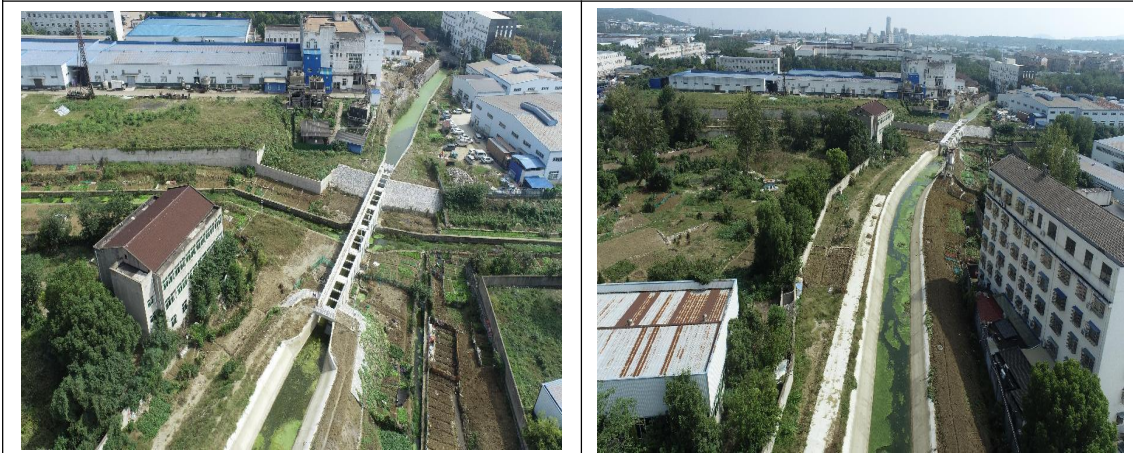
小张湾渡槽及 K14+400 北干渠 (2025.9.28)
