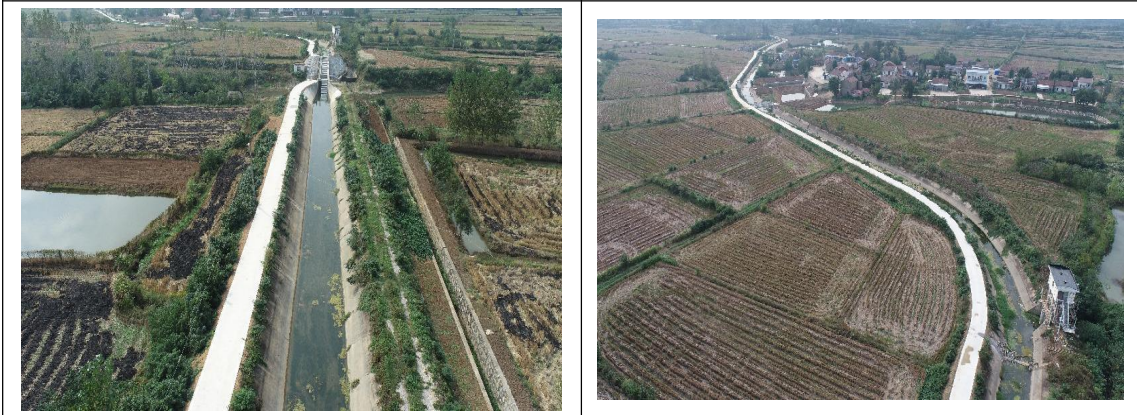
K34+100 北干渠及渠顶路 (2025.9.28)
