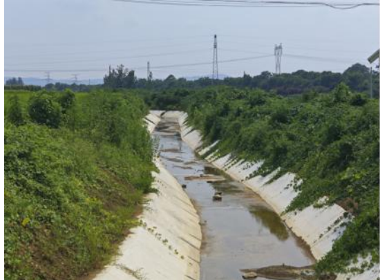
渠道播撒草籽 (2025.6.25)
