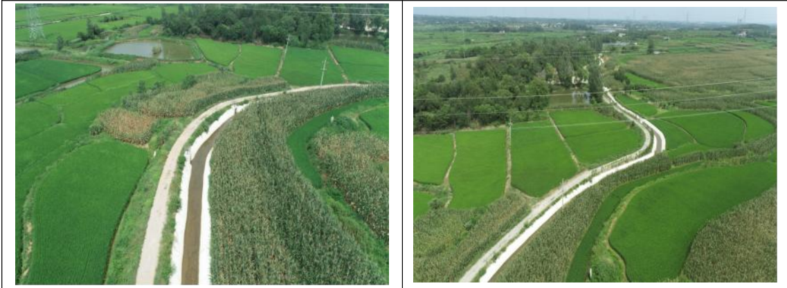
北干渠老一支航拍（2025.6.25）
