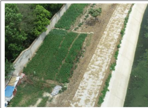
施工场地拆除后复耕 (2025.6.25)
