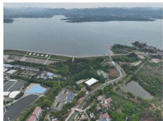
北干渠渠首航拍 (2025.5.19)
