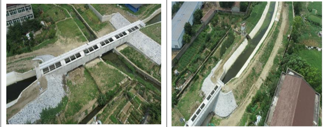
小张湾渡槽施工 (2025.6.25)
