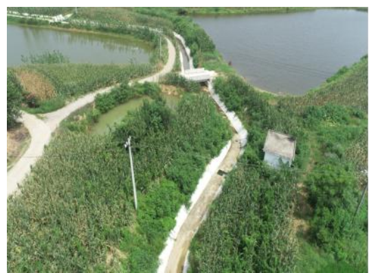
北干渠老一支航拍 (2025.6.25)
