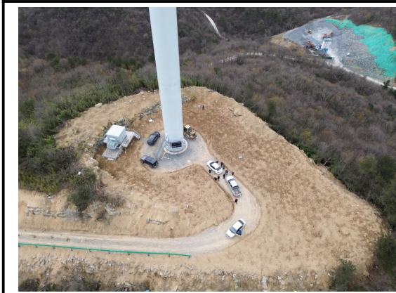
风电机组区表土回覆
