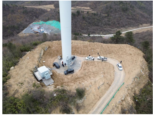
风电机组区表土回覆
