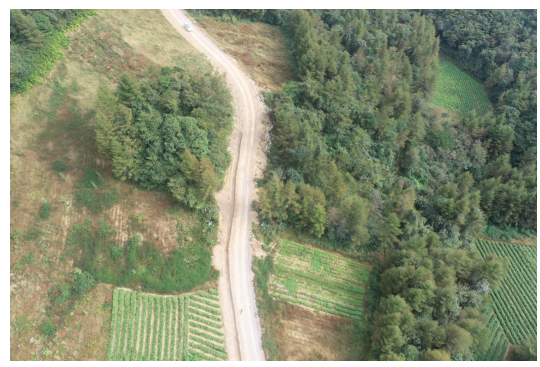
8#风机平台检修道路
