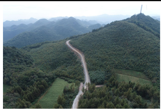
7#风机平台检修道路
