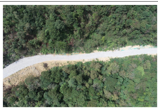
11#风机平台检修道路
