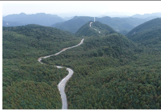
10#风机平台检修道路
