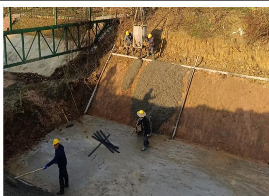
渠道混凝土护坡浇筑 (2024.12.30)
