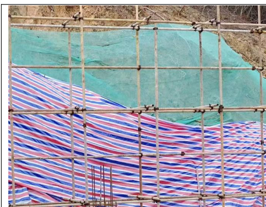
边坡临时苫盖 (2024.12.30)
