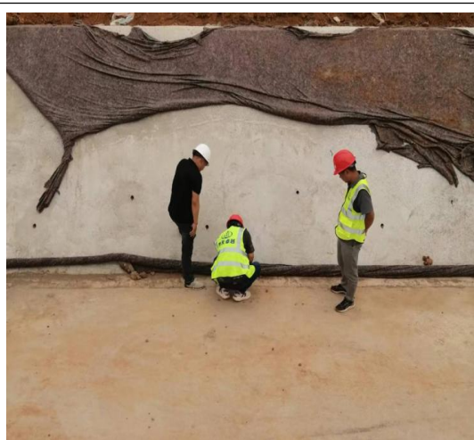
边坡混凝土养护
