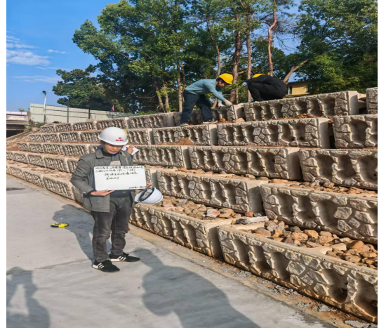
阶梯式生态挡墙及时完善植物措施
