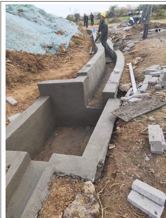
排水沟+沉沙池 (2024.12.30)
