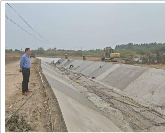
渠道底板施工
