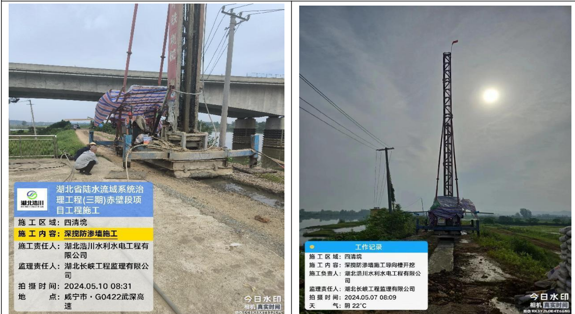
深搅防渗墙施工 (2024.05.10)
