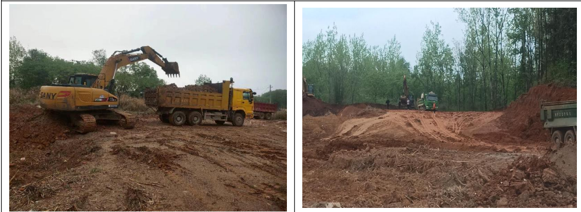
取土场土石方开挖运输 (2024.04.29)
