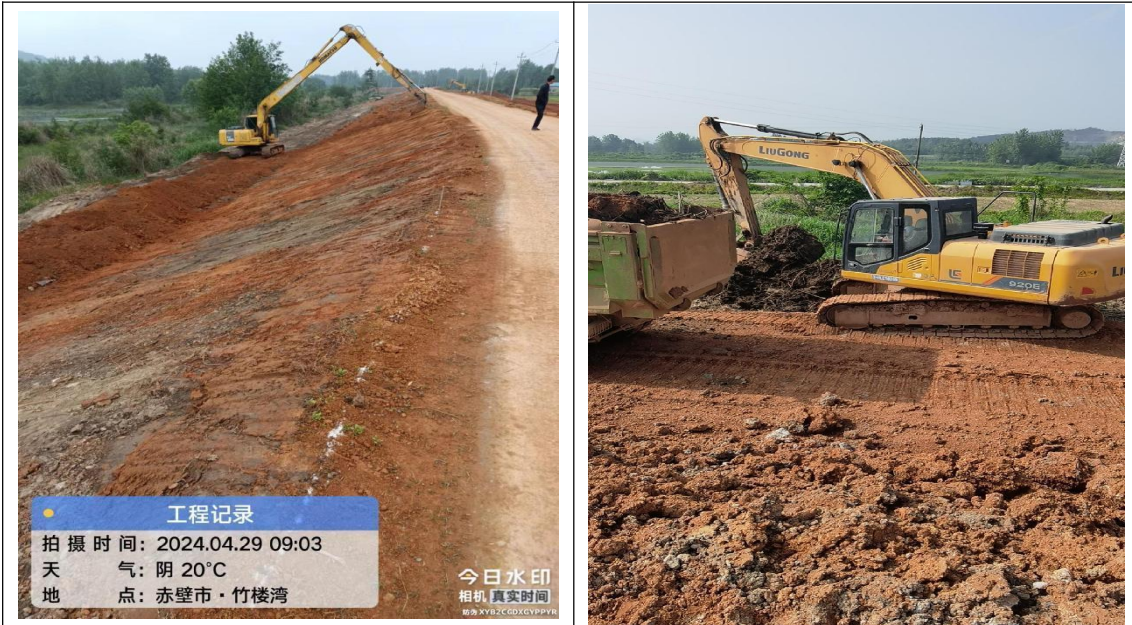
堤防加培土方回填 (2024.04.29)
