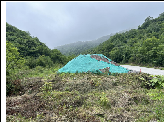
临时堆土苫盖措施
