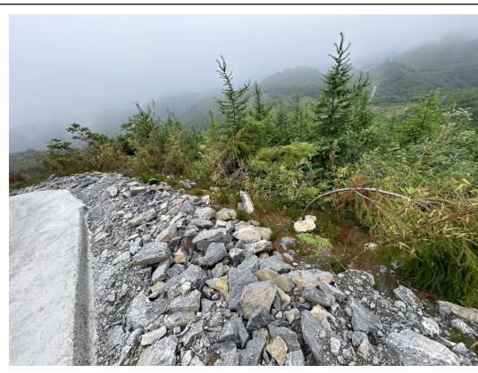
检修道路植物措施护坡
