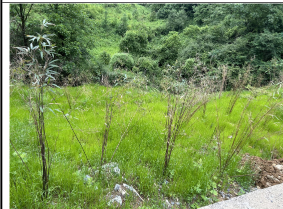
检修道路植物措施护坡
