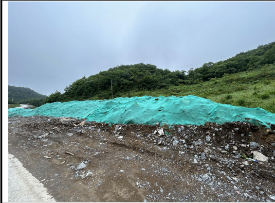
临时堆土苫盖
