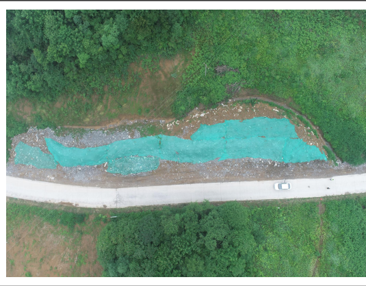
临时堆土排水沟、临时苫盖
