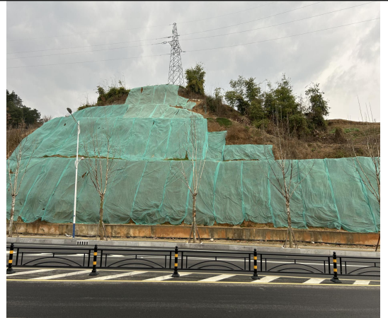
临时苫盖（2023年4季度）
