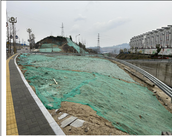
临时苫盖（2023年4季度）
