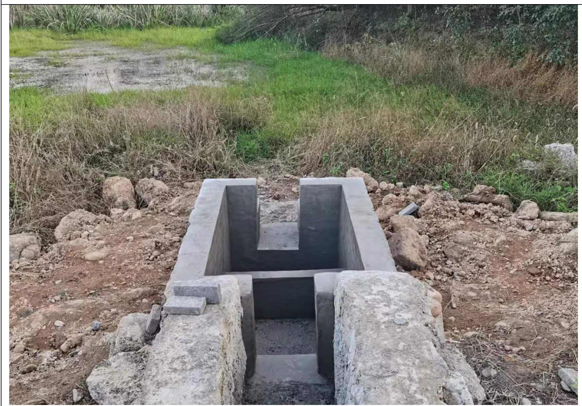
沉沙池监测点施工
