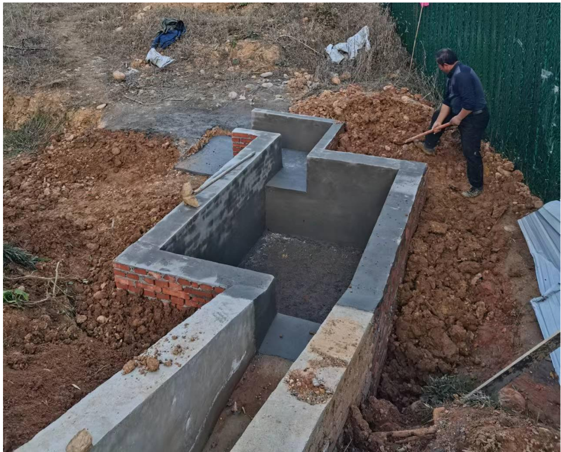
沉沙池监测点施工
