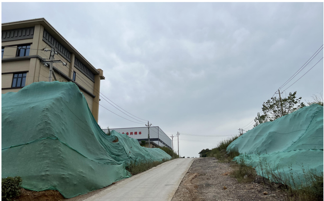
思睿新材料裸露边坡已苫盖
