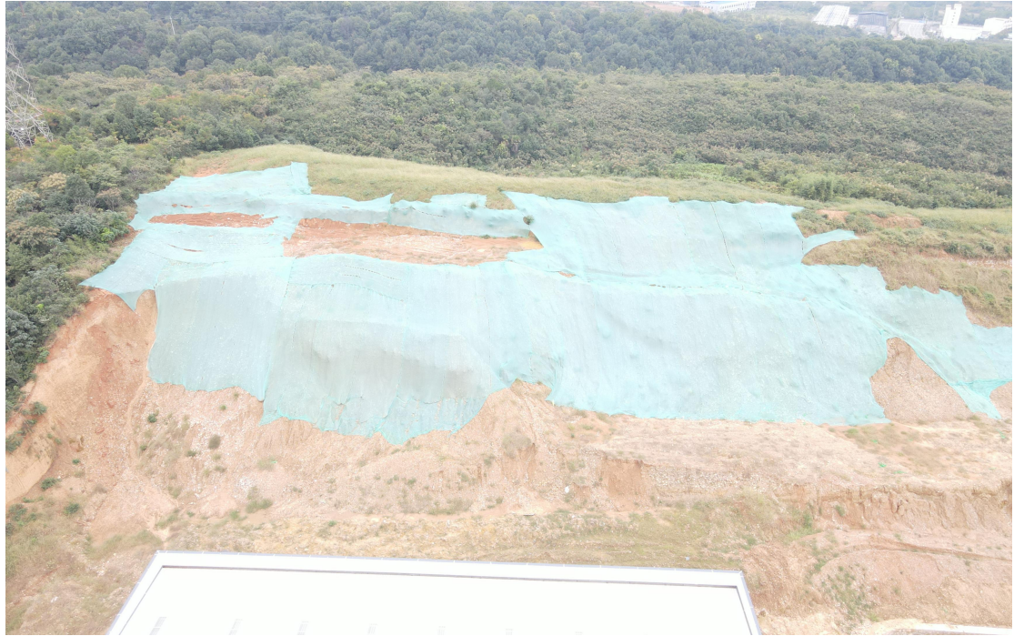
赤诚生物施工现场边坡已苫盖
