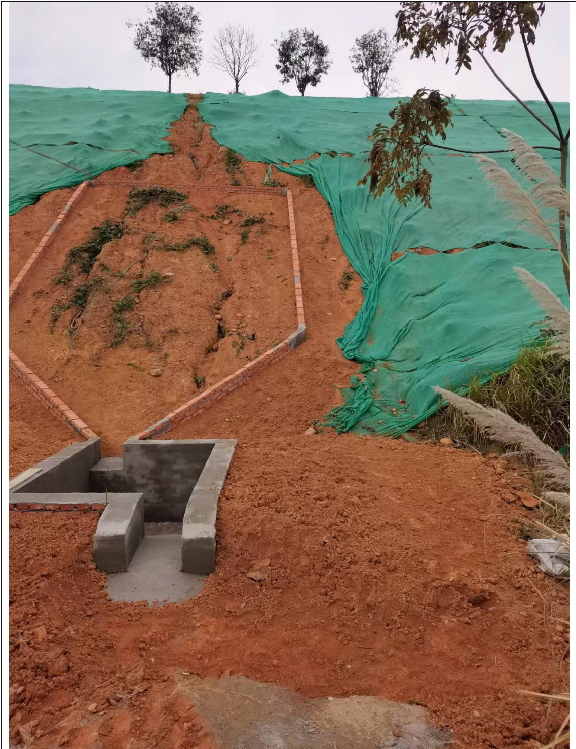
径流小区监测点施工
