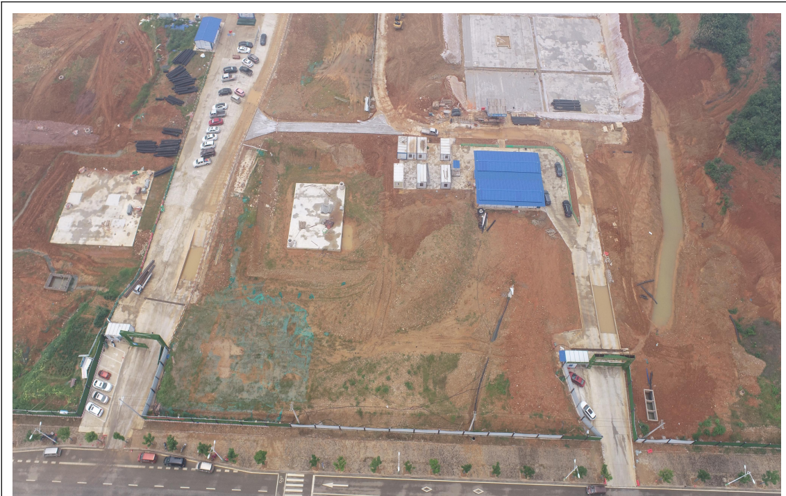
赤诚生物施工现场
