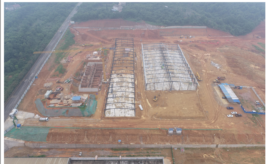
石墨烯及高边坡修复项目现场
