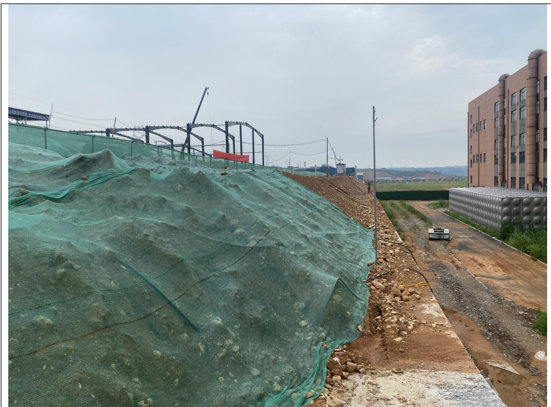
石墨烯项目临时苫盖
