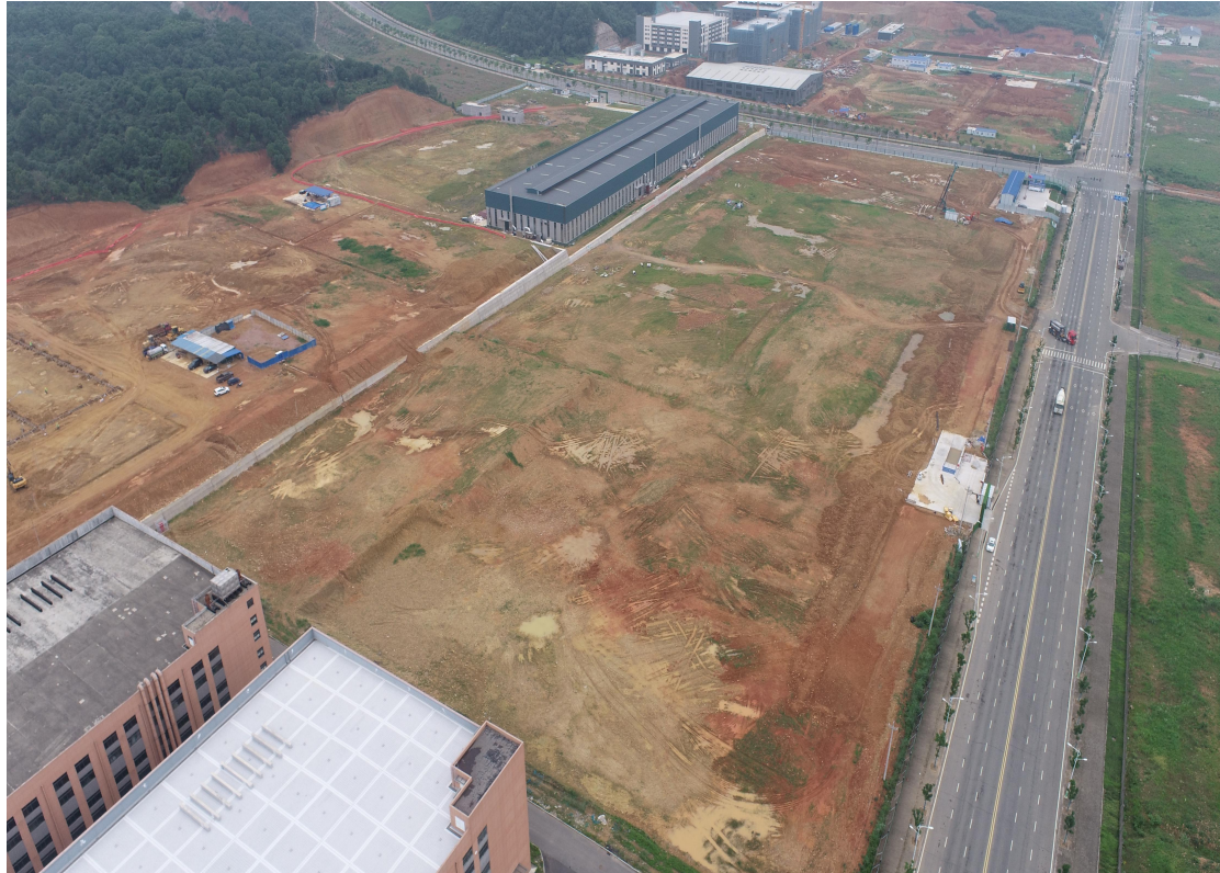
石墨烯、高档砂子、赤城生物项目施工现场
