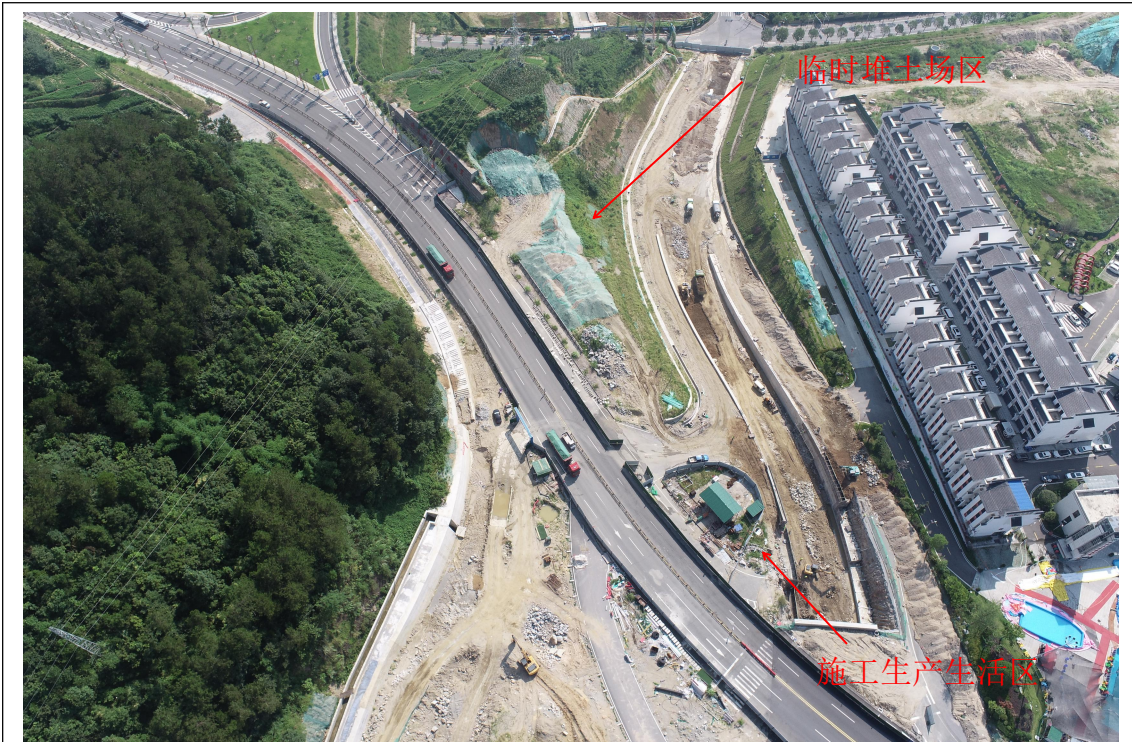
二期临时堆土场区、施工生产生活区（2023年2季度）
