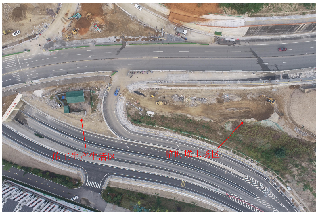
二期临时堆土场区、施工生产生活区（2023年3季度）
