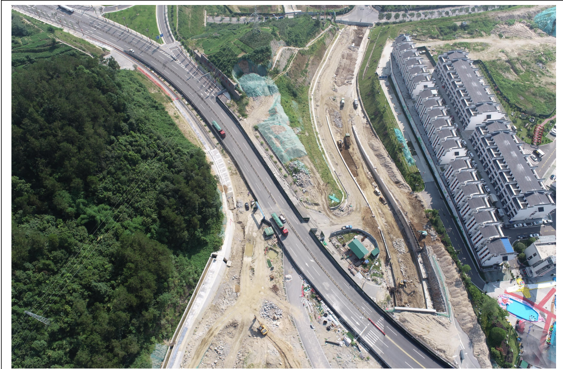
二期临时堆土场区、施工生产生活区
