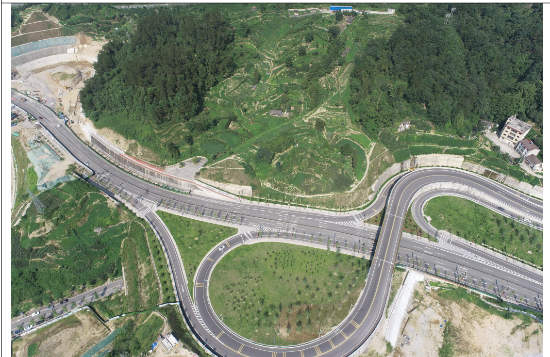
一期边坡恢复
