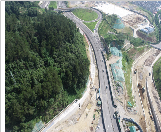
临时堆土场区（临时苫盖）
