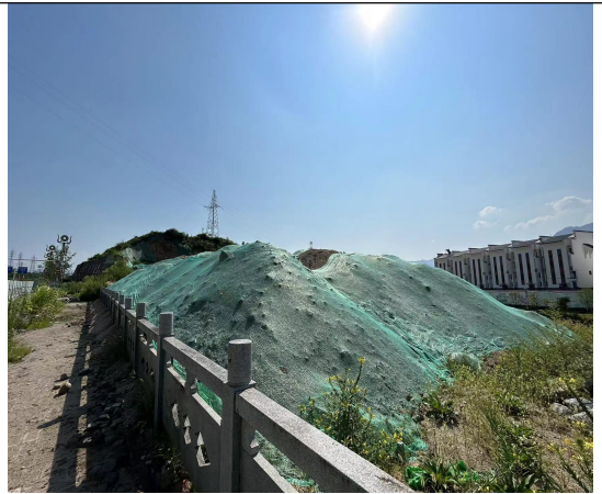
临时堆土场临时苫盖
