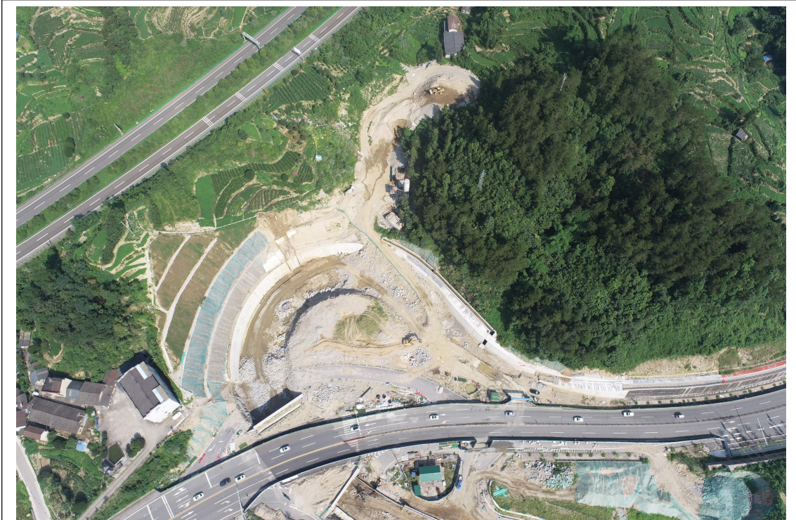
二期边坡防护施工
