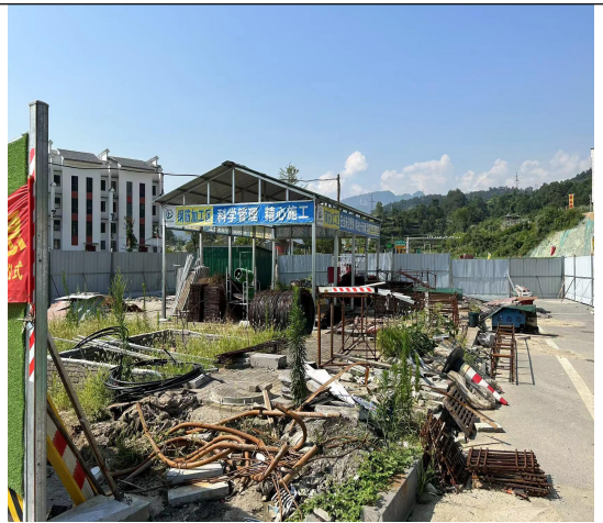
施工生产生活区
