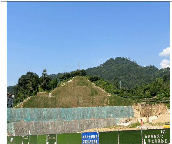
二圣路互通临时苫盖（2023年1季度）
