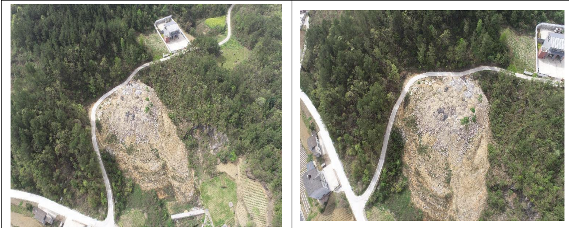
K21+920 弃渣场 (及时完善弃渣场排水, 对弃渣场进行表土回覆, 及时平整并完善植物措施)
