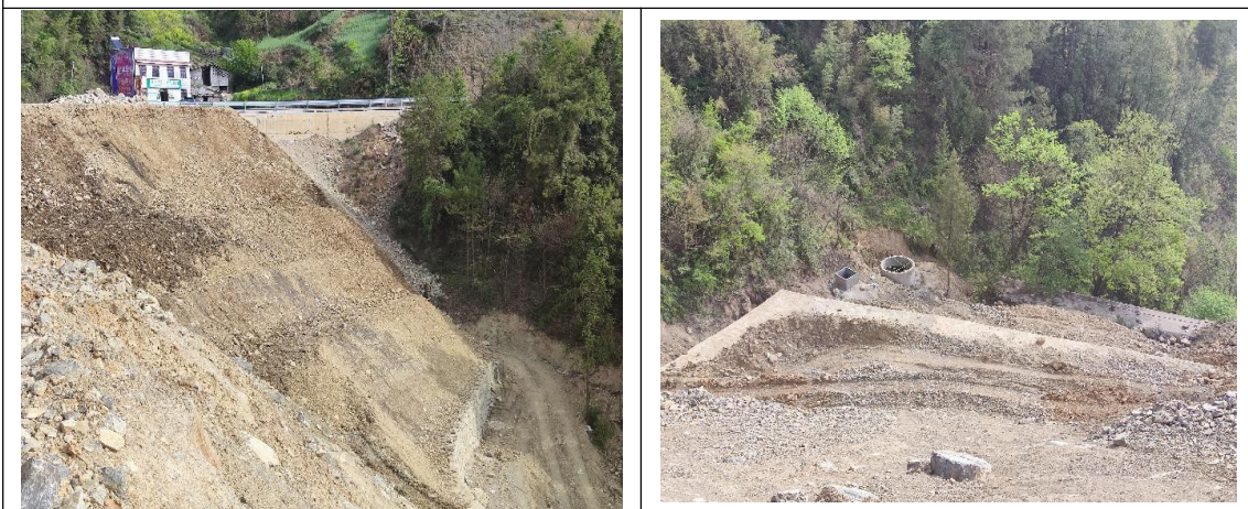
弃渣场分级放坡+挡土墙施工
