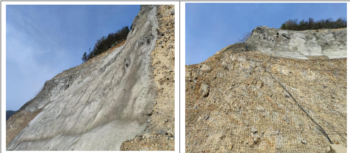
边坡喷锚治理
