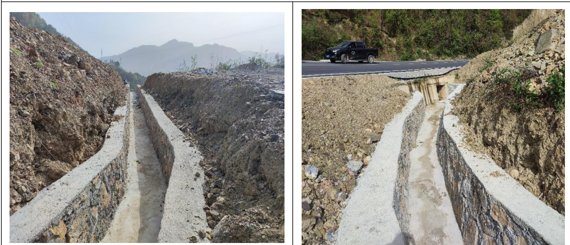
弃渣场排水沟
