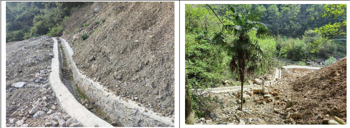
弃渣场排水沟
