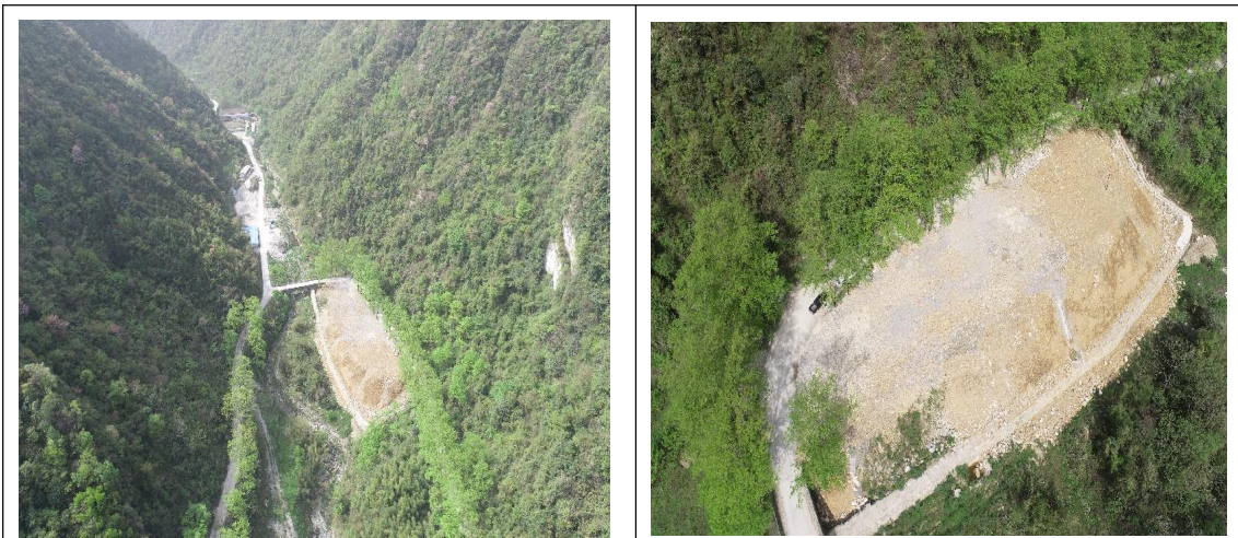
K17+500 弃渣场（完善植物措施）
