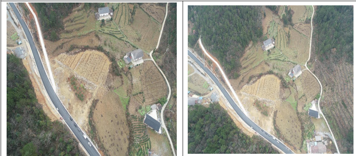
K21+580 弃渣场（及时进行植被恢复）
