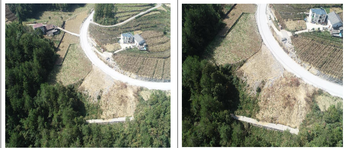
K21+080 弃渣场（及时进行植被恢复）
