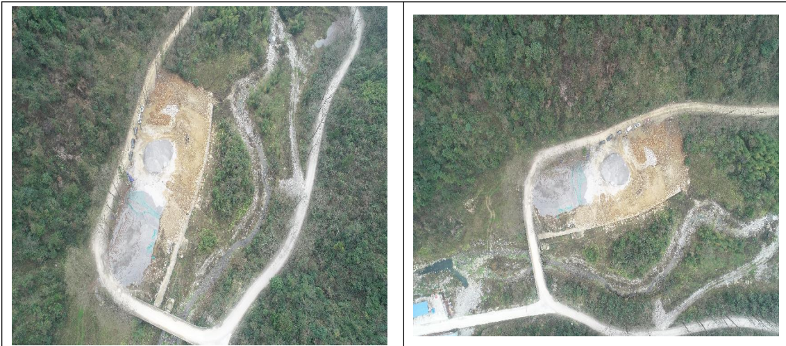
K17+500 弃渣场（边坡进行清理并及时削坡，完善挡土墙措施）
