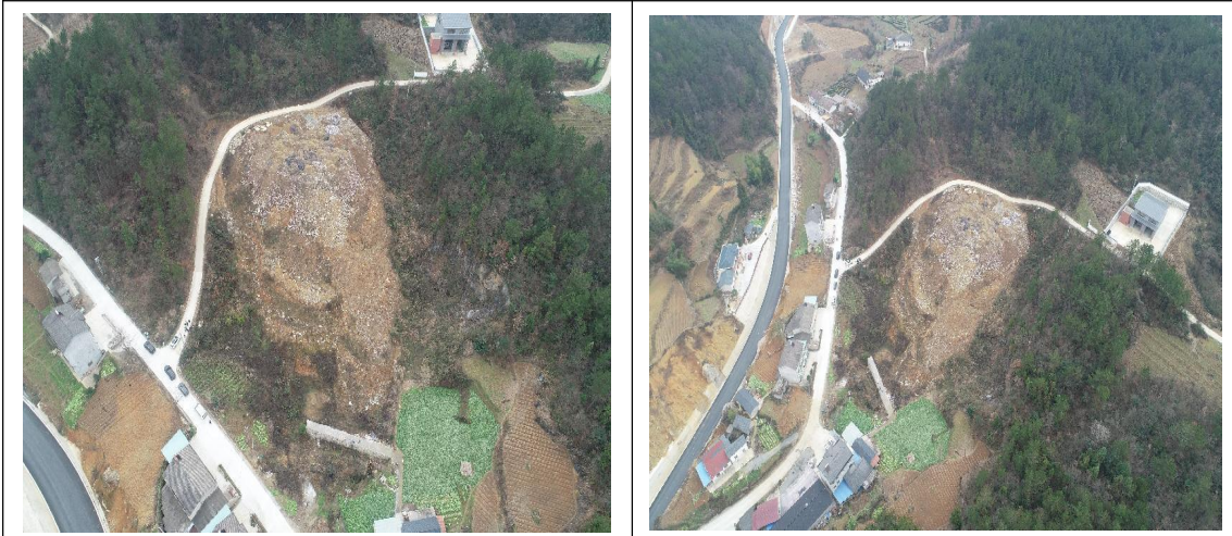
K21+920 弃渣场 (及时完善弃渣场排水, 对弃渣场进行表土回覆, 及时平整并完善植物措施)
