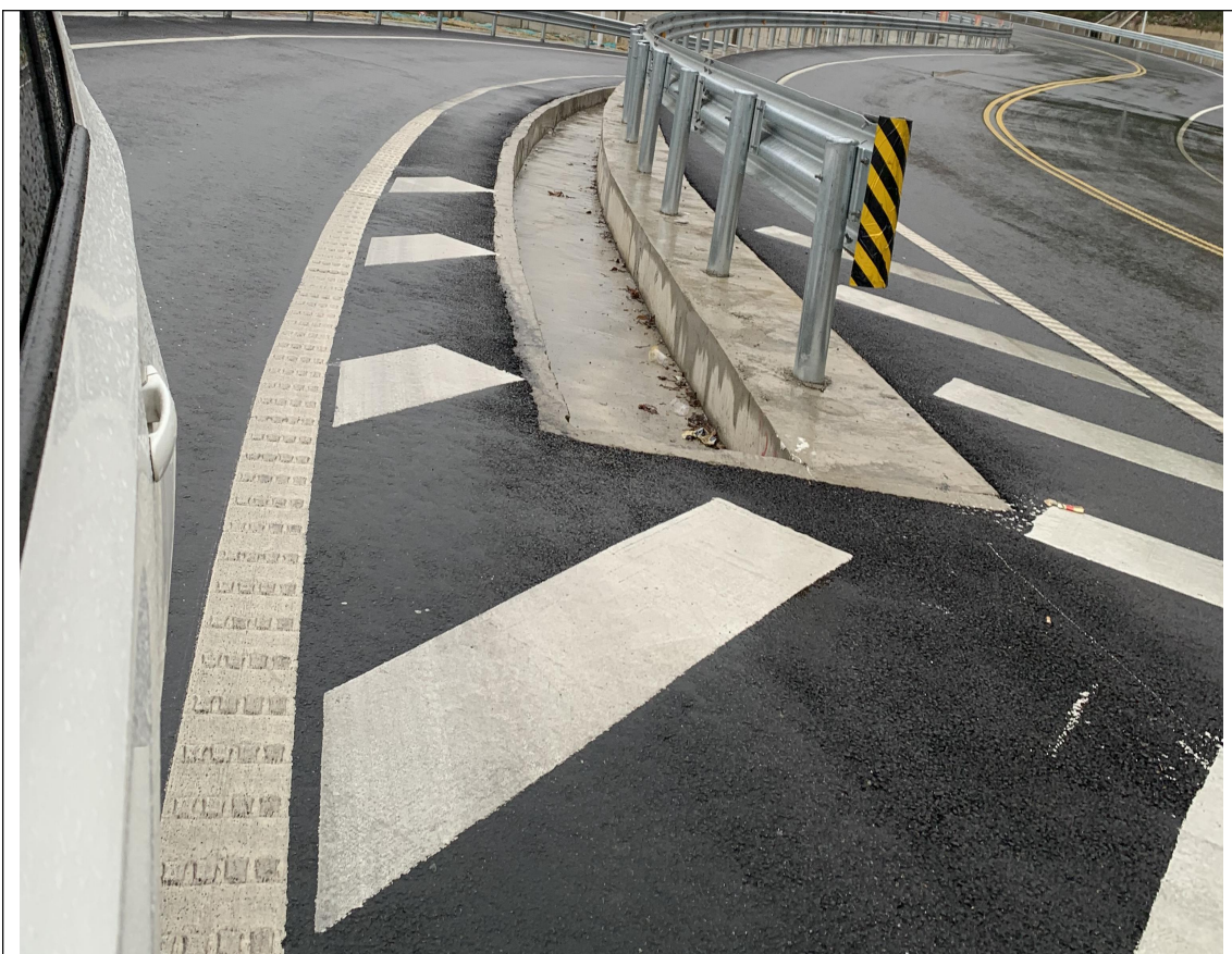
ZB、ZA 匝道排水沟
