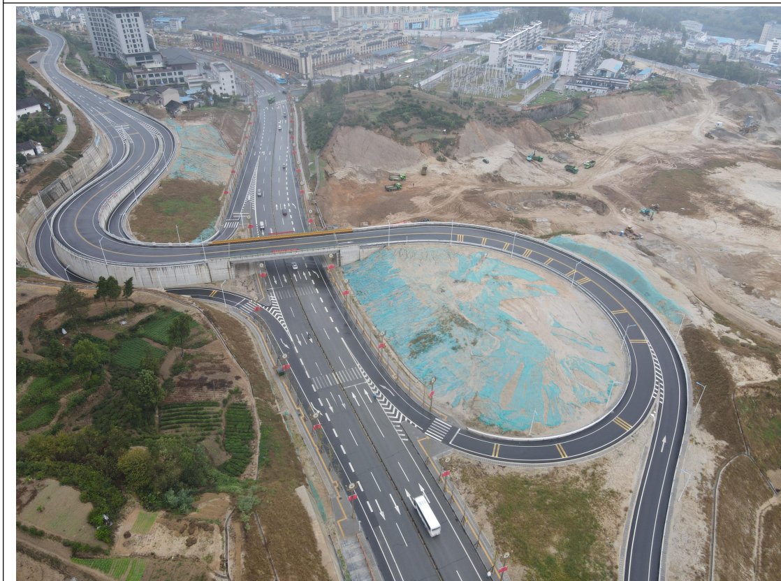
ZA、ZB 匝道、L 主线互通绿化处布置临时苫盖
