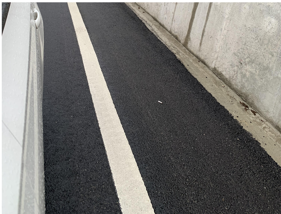
PA、PB辅路排水沟
