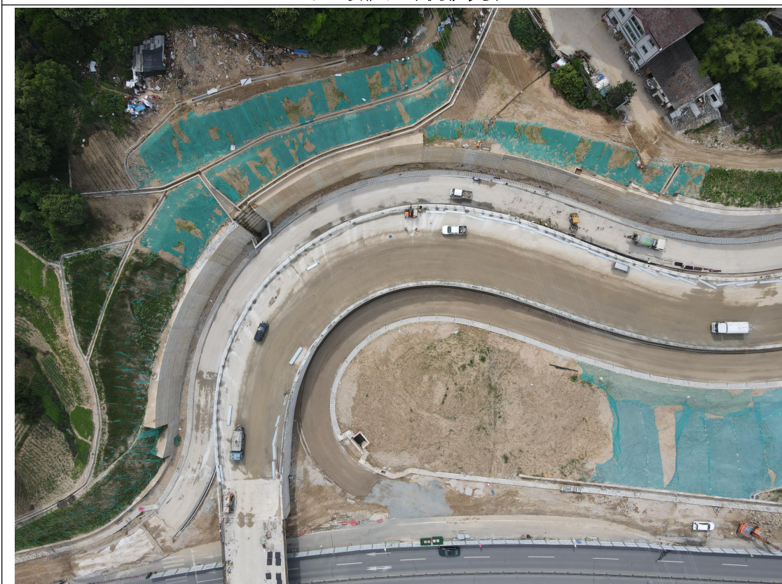
截水沟、排水沟、跌水沟
