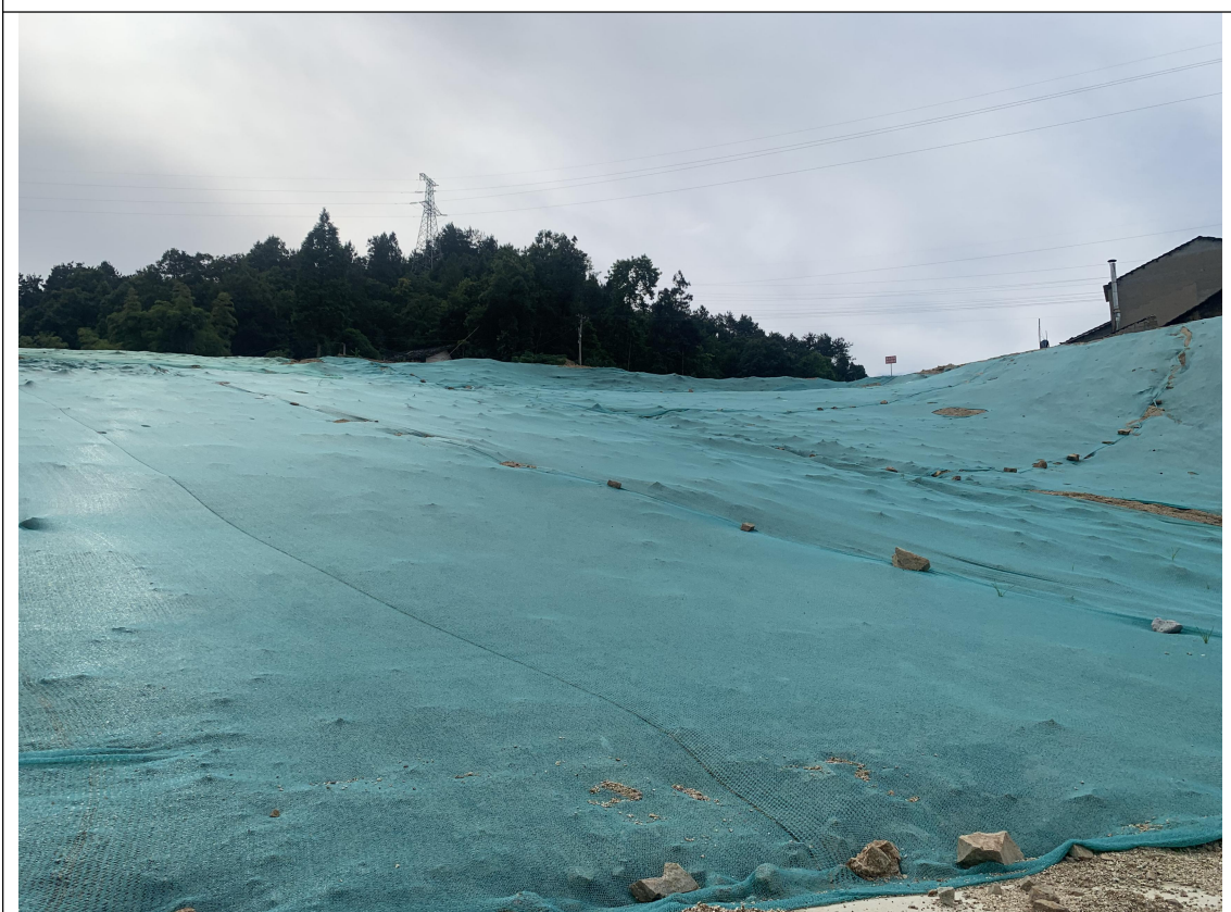
景观绿化区临时苫盖
