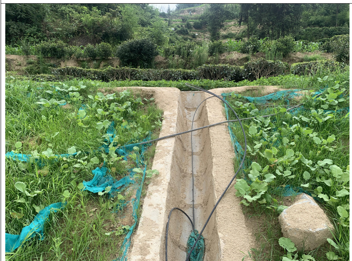
明珠大道西侧截水沟
