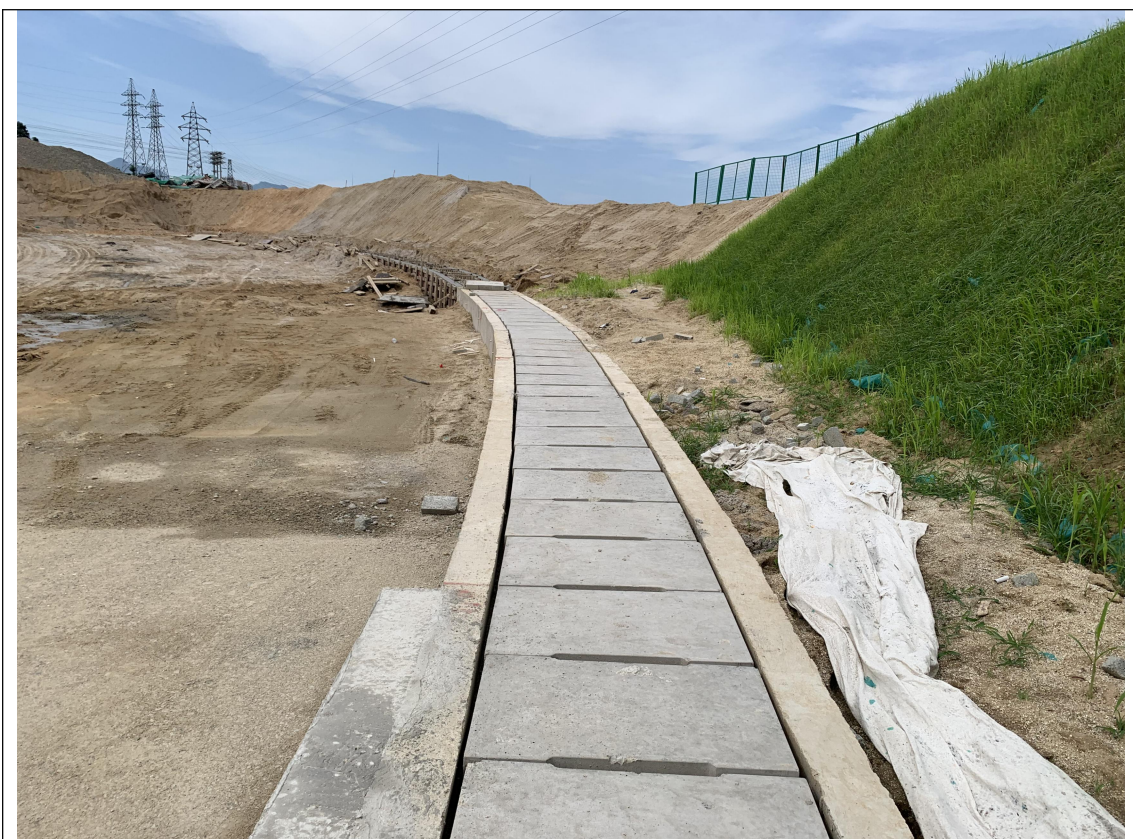
ZB 匝道排水沟
