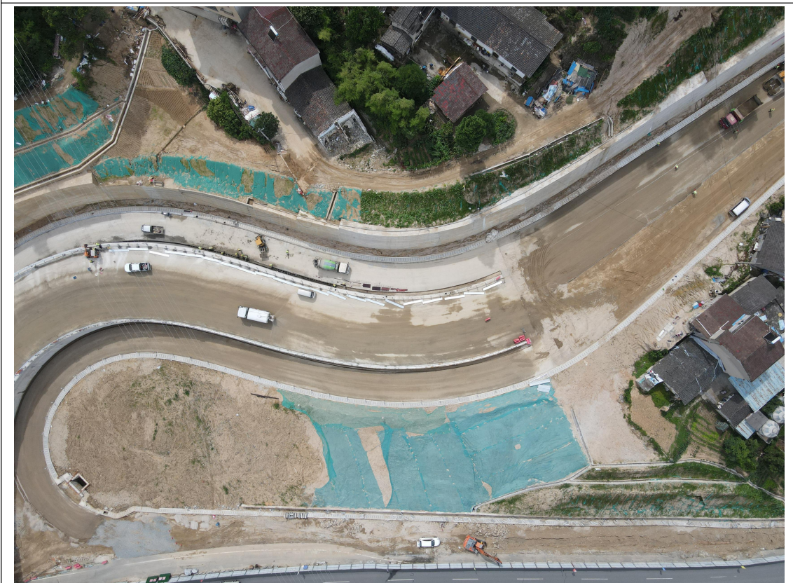
景观绿化区临时苫盖
