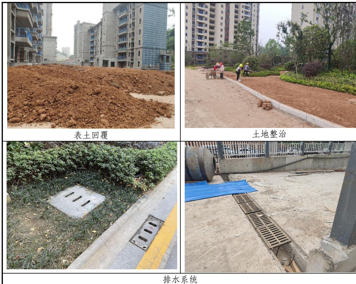
图 3-1 水土保持工程措施
